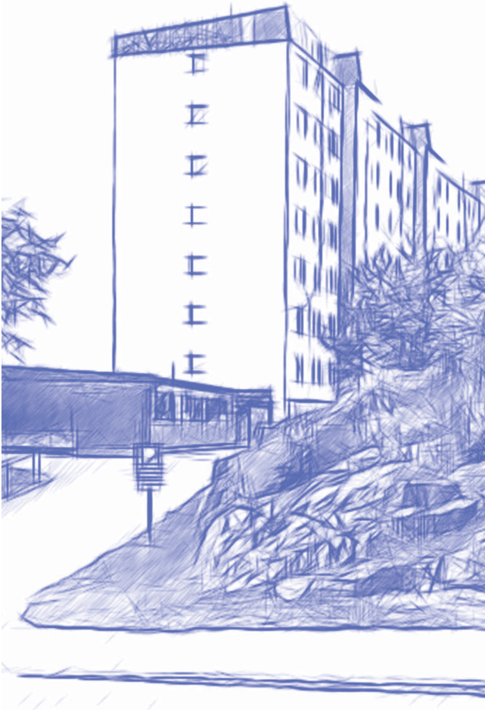
Minst två år tar arbetet med att fasadrenovera höghuset.
