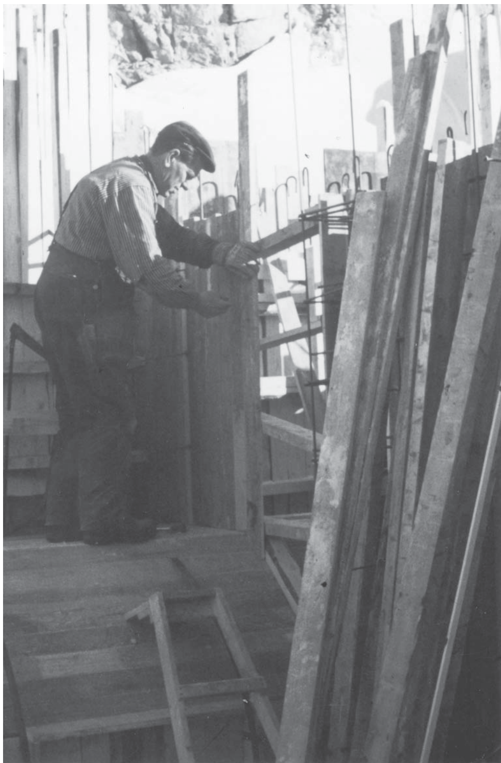
1962 bygger Skånska Cementgjuteriet de balkonger som renoveras (på sidan 33)
