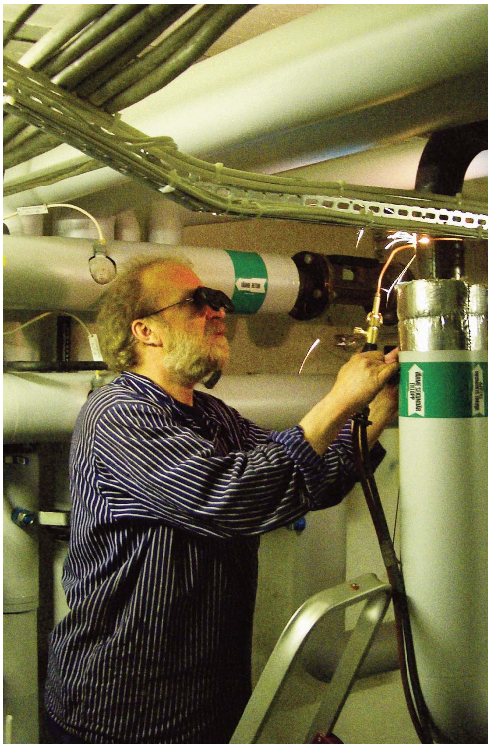
Underhållsarbeten i föreningens uppvärmningssystem.
